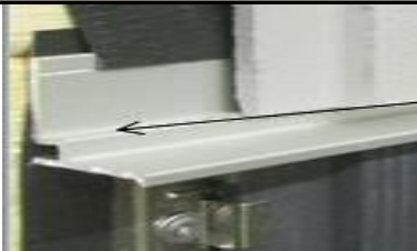
Стартовый профиль для вертикального монтажа Cedral Click
